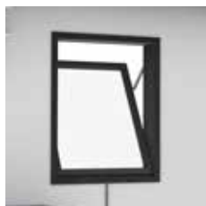
Evacuadores naturales de humo y calor, aberturas para la entrada de aire
